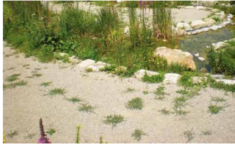
▲ Wassergebundene Flächen wie diese an einem Bachrand sind für Gartenwege ausreichend tragfähig und lassen Regenwasser hindurch.
